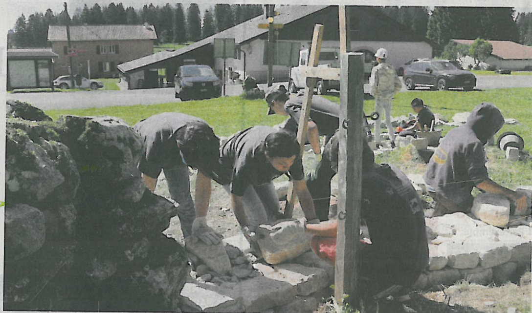
Cinq tonnes de blocs de calcaire ont été nécessaires pour ériger le mur.
