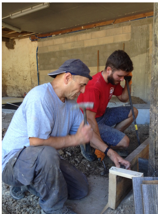
Schalung zimmern zum Betonieren © Foto: APD Schweiz
