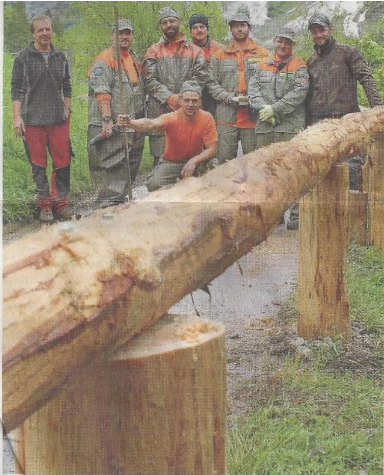
Unter Anleitung von Wegmeister Peter Zurbrugg (l.) hat eine Gruppe entlang des Fahrsträsschens einen neuen Sicherheitszaun errichtet.
