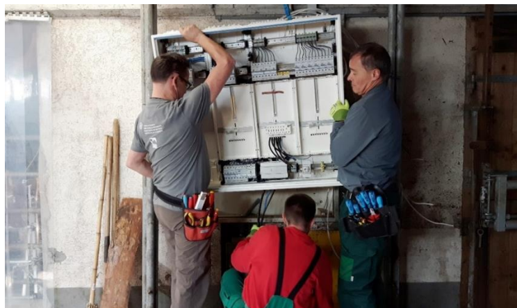
Ein von Hager Schweiz vorgefertigtes Elektrotableau wurde angebracht.
