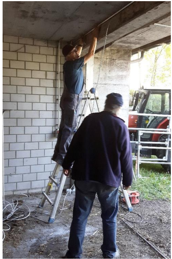
Dutzende Meter Kabel und Schutzrohre wurden verbaut.
