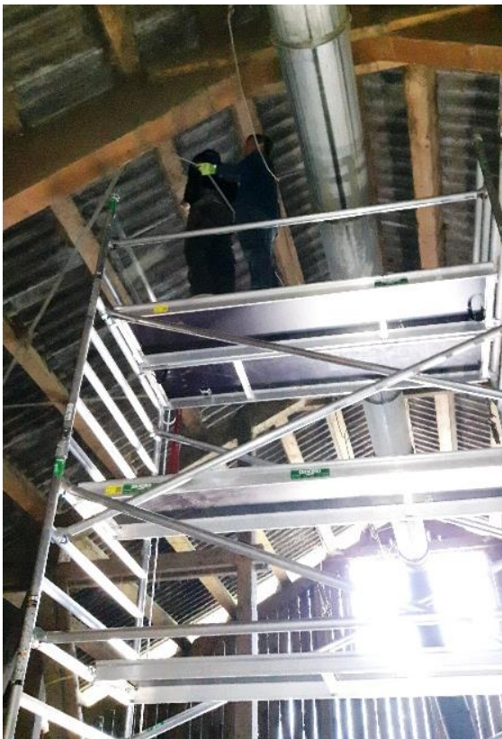
Spezielle Herausforderung auf dem eigens gemieteten Rollgerüst.
