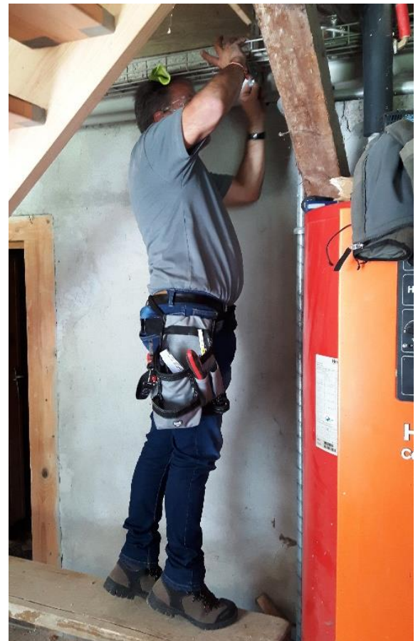
Kabelführungen werden neu befestigt.
