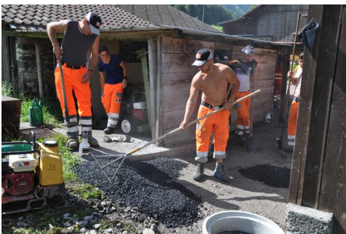
Mit den Karetten wird das Belagsmaterial an Ort und Stelle gebracht; begonnen mit dem Einbringen wird im hintersten Punkt des Hofplatzes.
