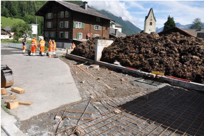
Verstärkung der befahrbaren Fläche durch Armierung im Bereich der Hofdüngeranlage.
