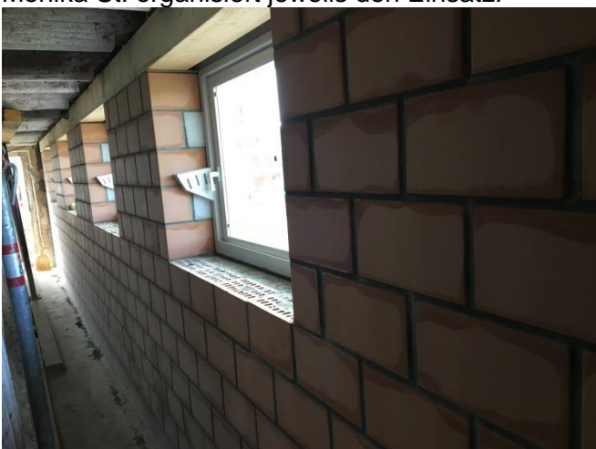
Die neue Stallausssenwand von Innen.
