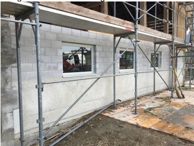
Die neue Stallmauer lässt sich sehen.
