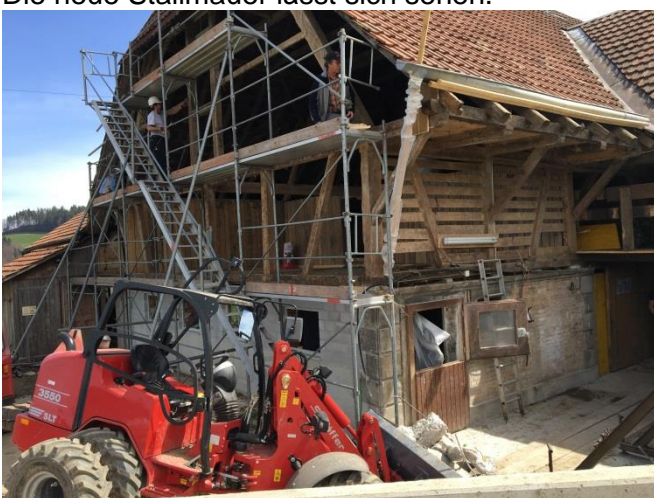
Die Giebelwand musste erneuert werden.
