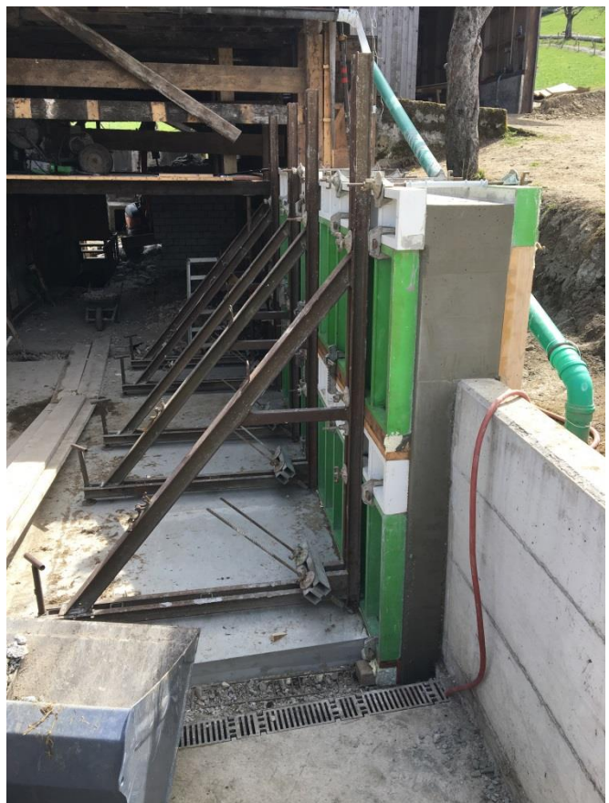
Einheitige Schalung. Topp Material der GLB.
