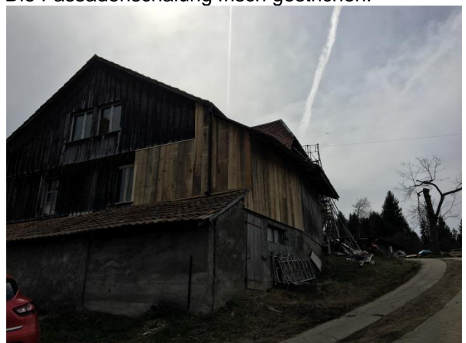
Teilerneuerung der Fassade.
