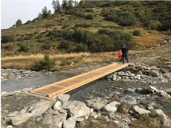
Holzsteg mit neuem Bodenbelag
