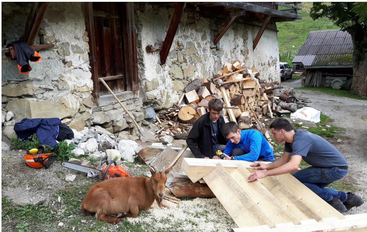
Erstellung und Montag der Treppe zum Keller unter vierbeiniger Aufsicht...
