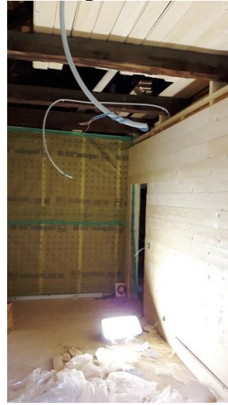
Umbauarbeiten im Dachstock
