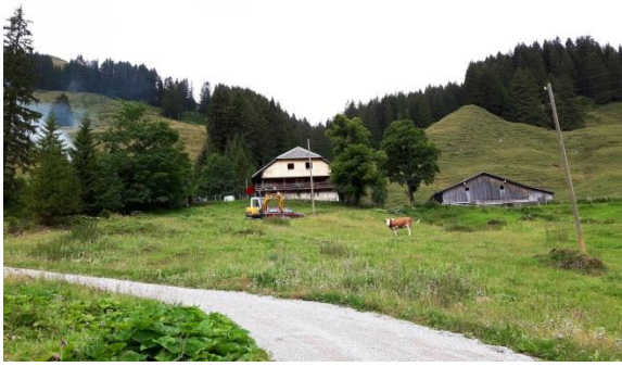
Die bereits neu erstellte Fassade (Obergeschoss) ist gut ersichtlich
