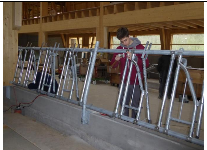
Montage der Fressgitter
