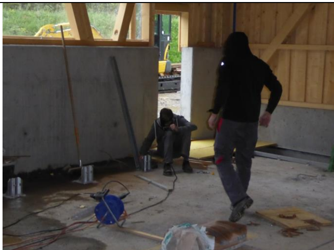
Fussplatten werden in die Betonplatte geschraubt
