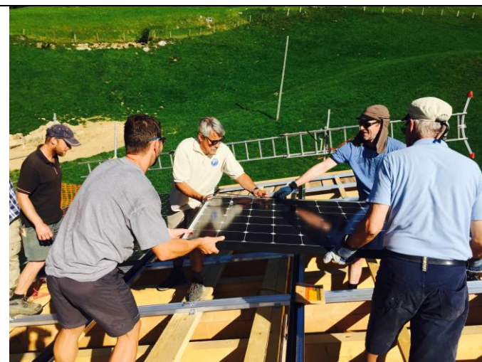
Sorgfältig werden dann die Solar Panels verlegt, befestigt und mit dem System verkabelt
