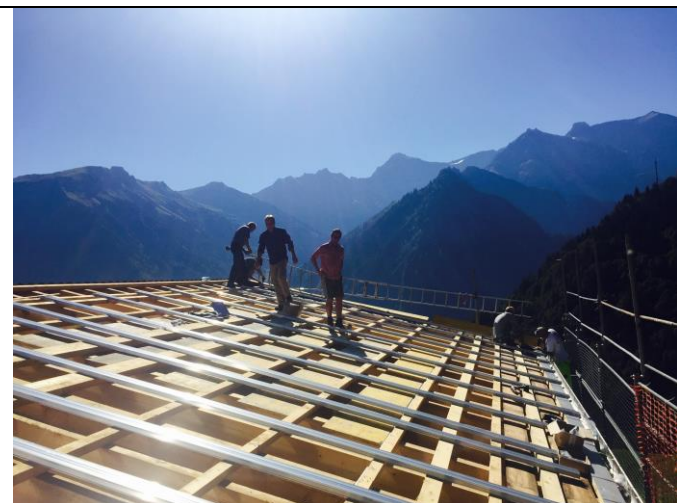
Das Dach wird für die Installation der Solar Panels vorbereitet
