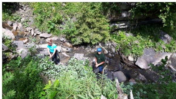
Die abgeschnittenen Äste müssen mit Seilen nach oben gezerrt werden.
