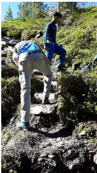
mit Steinen werden Treppenstufen angelegt
