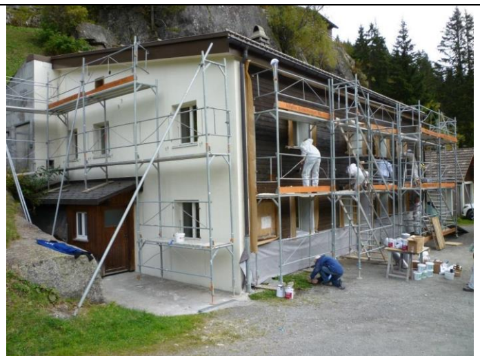
Auch die Seitenwand und der Windfang bekommen ein neues Kleid
