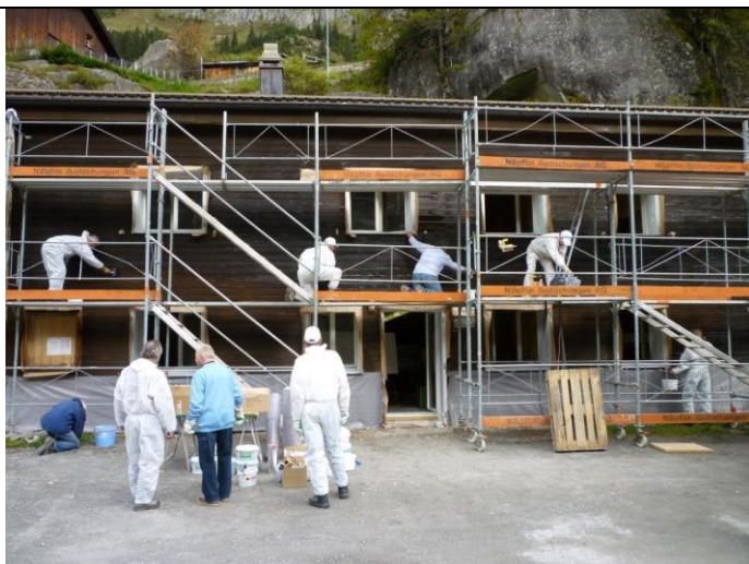
Die Holzfassade erhält einen neuen Anstrich
